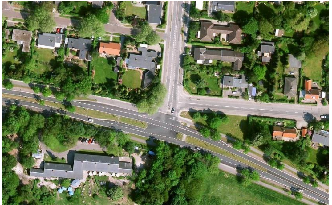
Figur 1: Krydset Klampenborgvej/Hjortekærvej i dag.
